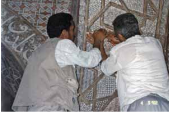
أعمال ترميم المدرسة العامرية - رداق
