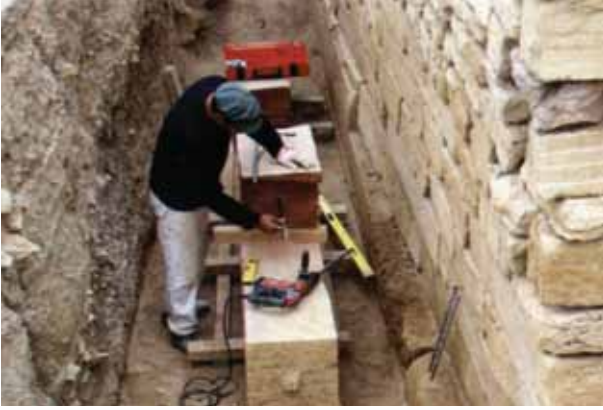
من أعمال ترميم معبد نكرح-براقش- البعثة الإيطالية
